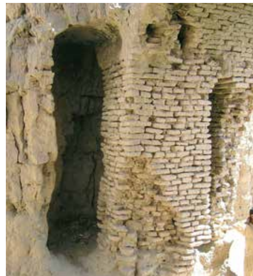
Fig. 1380 Recess for rolling stone door
