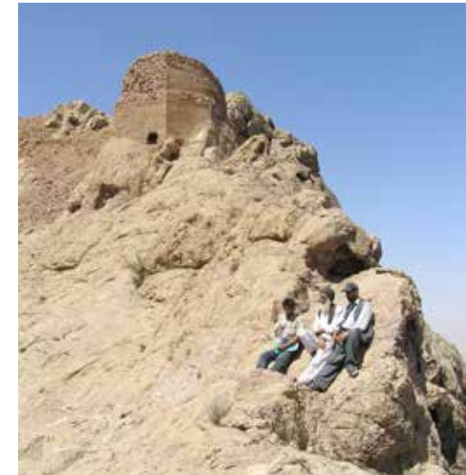
Fig. 1077 Tower of Qal'e Essar, Kafer Qal'e (Gz 5)
